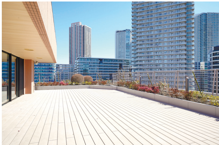
スカイラウンジ
